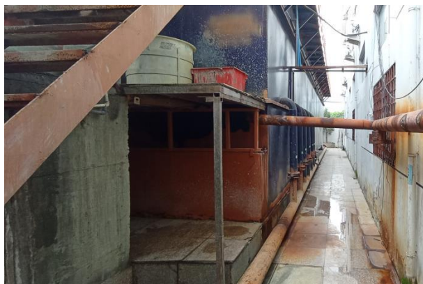
图 5.2-2 废水处理池体
