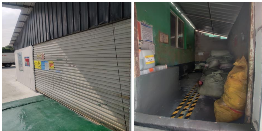
图 3.3.5-2、图 3.3.5-3 厂区东北侧污水处理区危废暂存间
