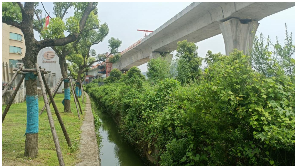
图 2.2-2 企业东侧现状（引水渠及轨道交通 S2 线）
